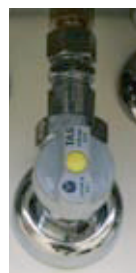
Pildil: gaasiühendus. Väljatungiva gaasiga kaasneb mürgitus- ja plahvatusoht.
