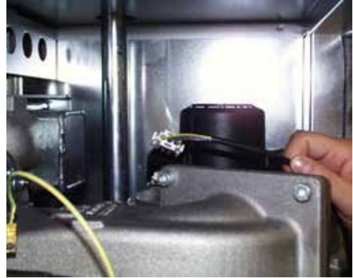
Joonis. Puhuri ja süütetrafo kõikide elektriühenduste avamine
