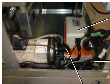
Kondensaadi kergituspumba ja neutraliseerija ühendus
