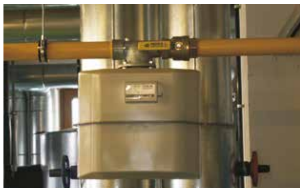
Joonis. Gaasiühendus: väljatungiva gaasiga kaasneb mürgitus- ja plahvatusoht.
