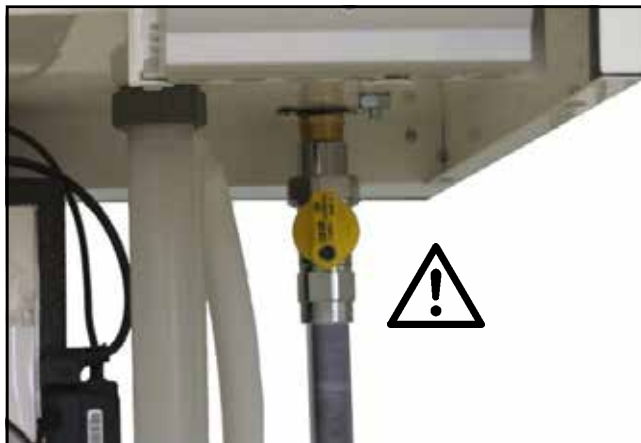
Joonis. Gaasiühendus Väljatungiva gaasiga kaasneb mürgitus- ja plahvatusoht.
