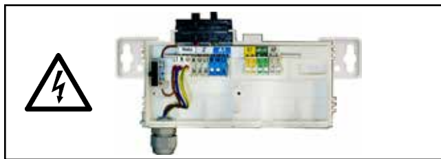
Joonis. Klemmikarp: ohtlik elektripinge!
