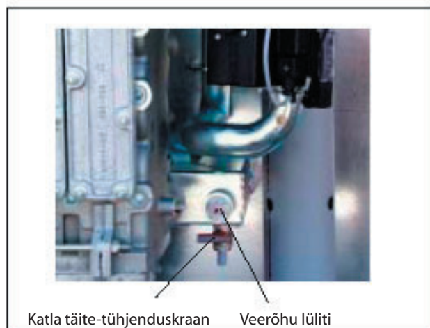
Joonis: Katla täite-tühjenduskraan
